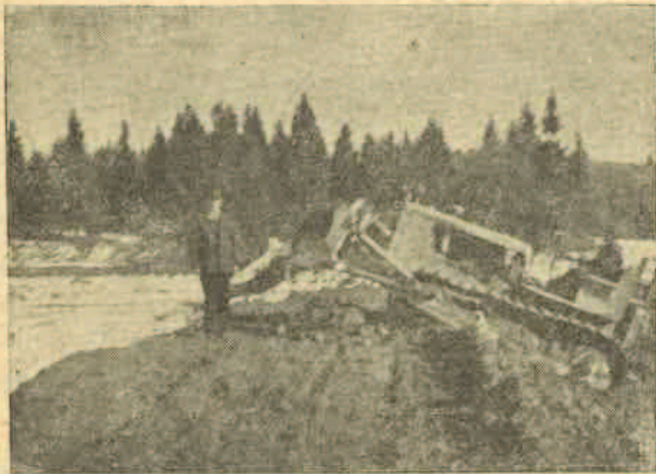
Sl. 6 — Gradnja ribnjaka u Ivancu Foto: Ing. Fijan
