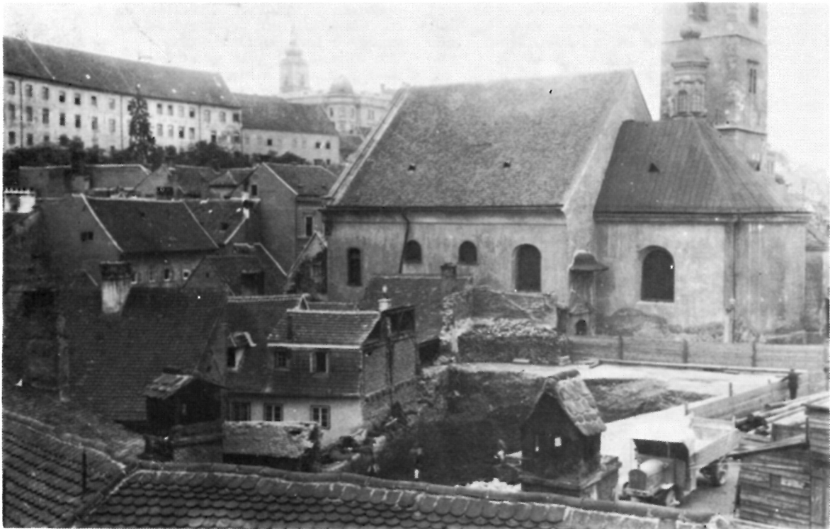
U toku rušenja povijesnog kompleksa na dijelu Dolca i ulice Pod zidom
