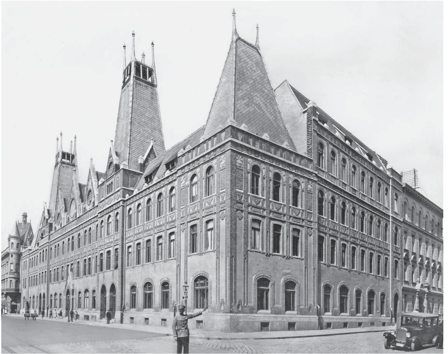
FIG. 1 PALACE OF THE POST AND TELEGRAPH ADMINISTRATION OFFICE IN JURISICEVA STREET, BETWEEN 1926 AND 1929 SL. 1. PALAČA RAVNATELJSTVA POŠTE I BRZOJAVA U JURISICEVOJ ULICI, SNIMLJENA IZMEĐU 1926. I 1929. GODINE
