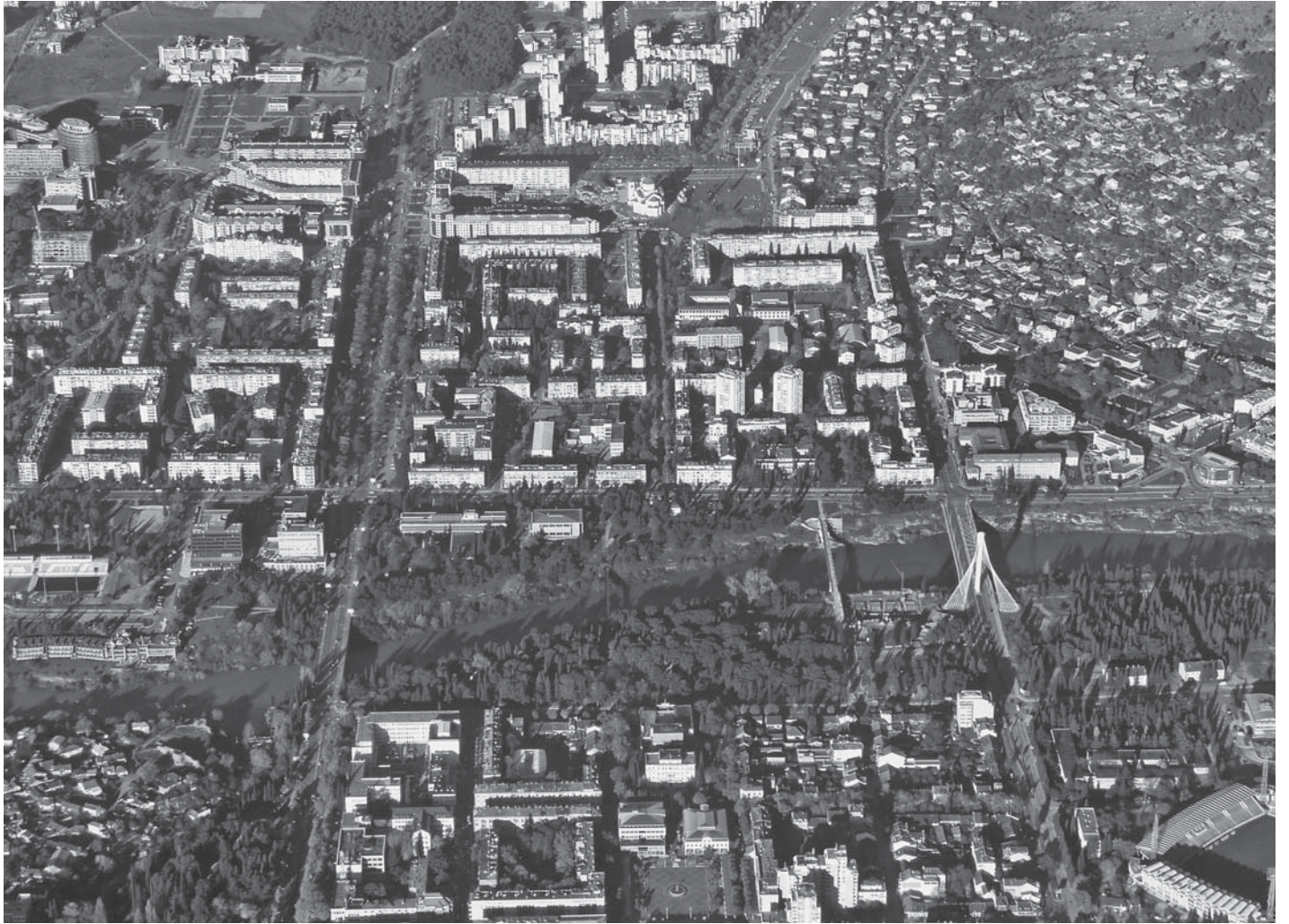
FIG. 1 AERIAL VIEW OF CENTRAL PODGORICA BY THE CONFLUENCE OF RIBNICA AND MORAČA RIVER SL. 1. ZRAČNA SNIMKA SREDIŠNJEG DIJELA PODGORICE POKRAJ USĆA RIBNICE U MORAČU
