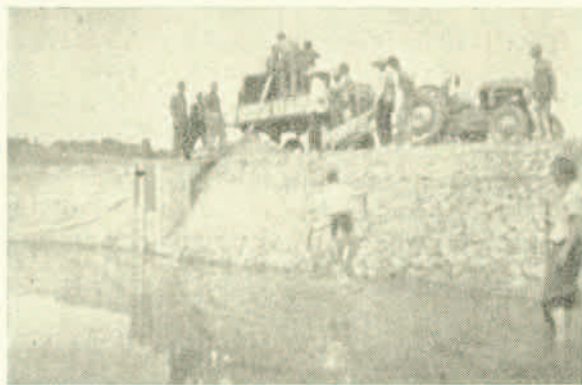
Gradnja ribnjaka Varaždin-Breg Foto: ing. Fijan
