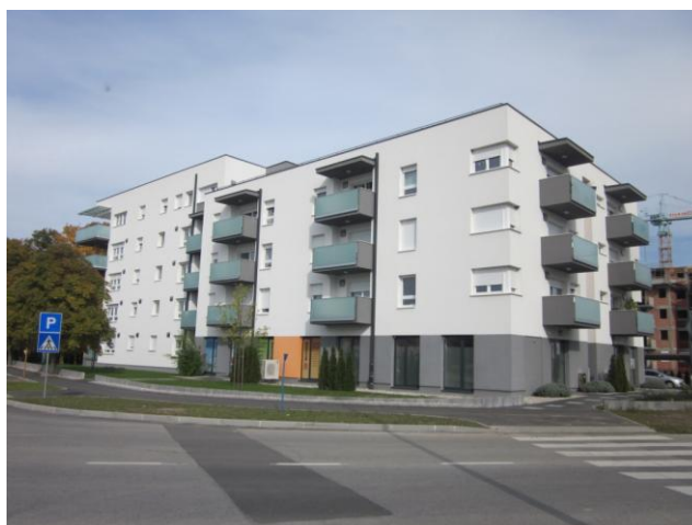
Slika 3. Pogled na zgradu „A“ s jugozapadne strane
