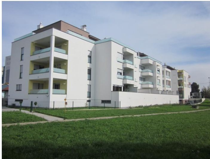
Slika 6. Pogled na zgradu „D“ s istočne strane
