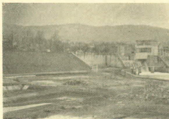
Brana na akumulaciji Sabljaci
