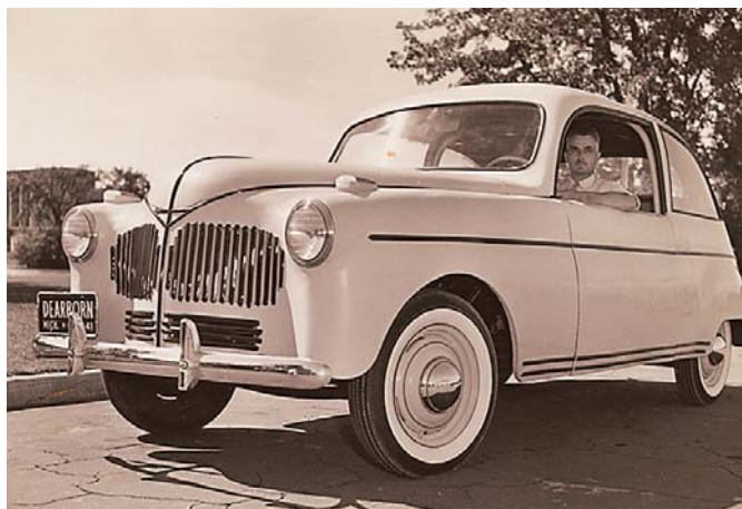
SLIKA 1 – Fordov automobil od duromernog kompozita s konopljom 2
