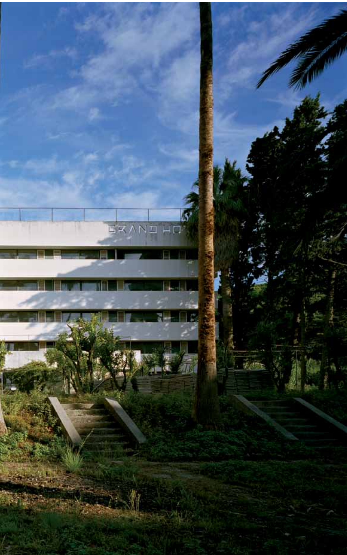
Grand hotel s parkom u rekonstrukciji, 2011.
