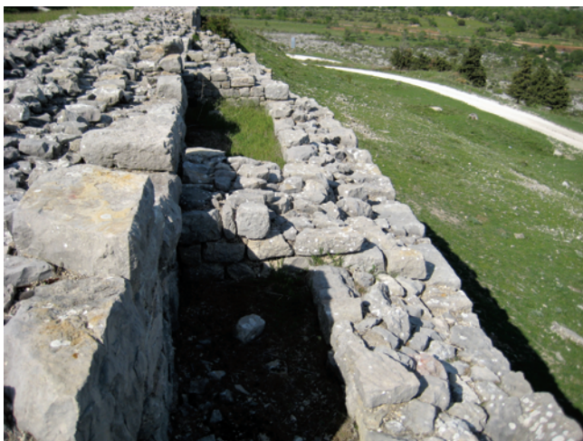
Slika 10 a-b. Potpornjaci povezani zidom Figure 10 a-b. Buttresses connected with a wall foto / photo: R. Sekso
