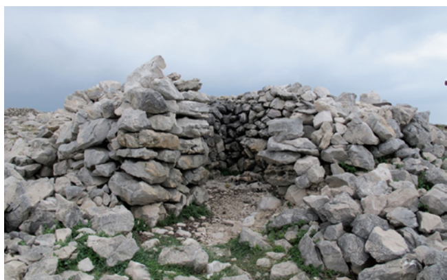
Slika 16. Suhozidni objekt unutar kule B2.2 Figure 16. Drywall structure inside tower B2.2
