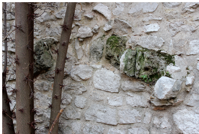
Slika 14. Blokovi sedre na presječenome svodu niše s južne strane do svetišta stražnje kapele u sklopu crkve sv. Petra Starog
