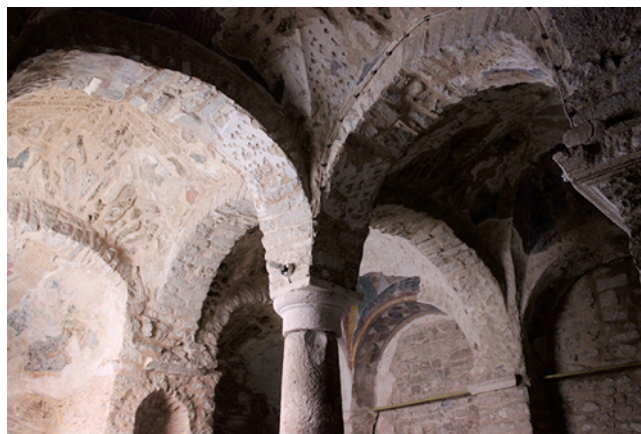
Slika 12. Križni svodovi u travejima svetišta i pred njim u stražnjem oratoriju sklopa Sv. Petra Starog
