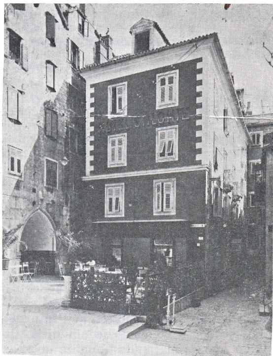
Zgrada za koju se misli da je bila stojna kuća obitelji Ivana Petra Marchi
