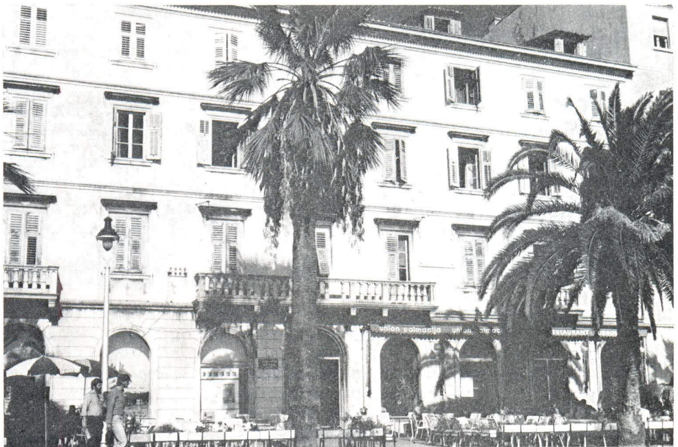
Zgrada u kojoj se nalazila Slavjanska čitaonica
