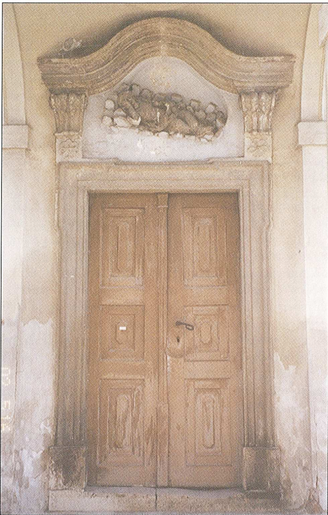
Sl. 5. Glavni portal
