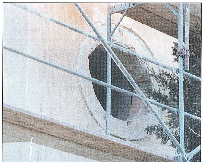
Sl. 7. Sjeverni zid pročelja s otvorenim okulusom
