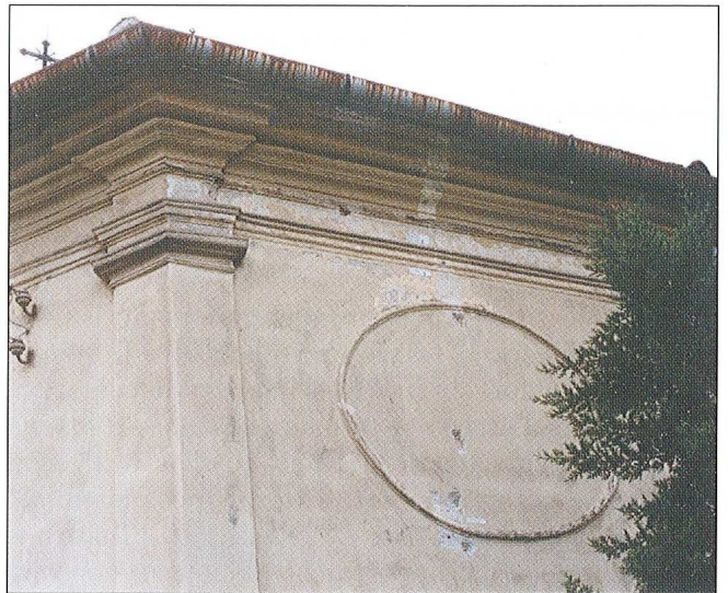
Sl. 6. Sjeverni zid pročelja sa zazidanim okulusom
