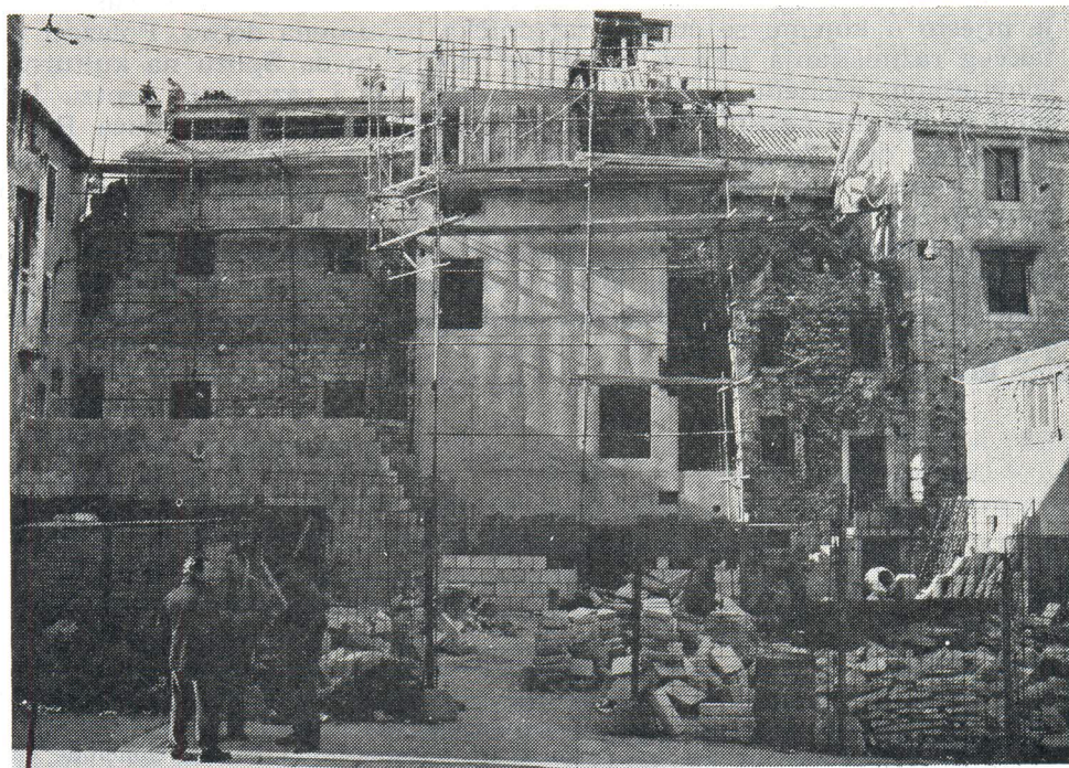
Radovi na zgradi Muzeja grada Splita, sjeverno pročelje, foto: Z. Buljević
