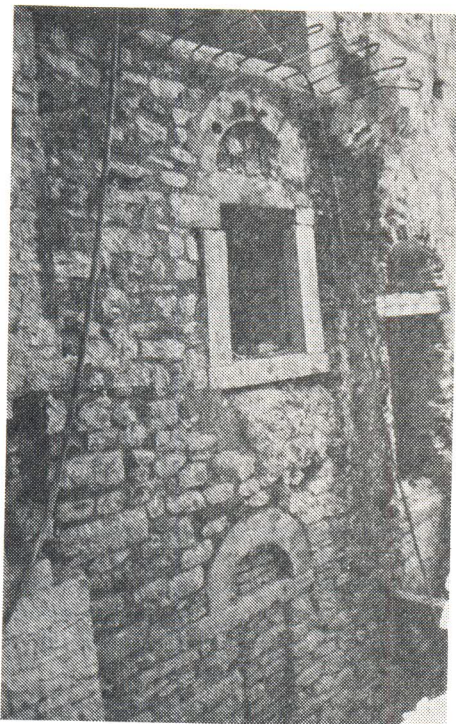
Sanacija MGS 1988. II faza zid uz porušeno stepenište na 1. i 2. katu, neg A-12554
