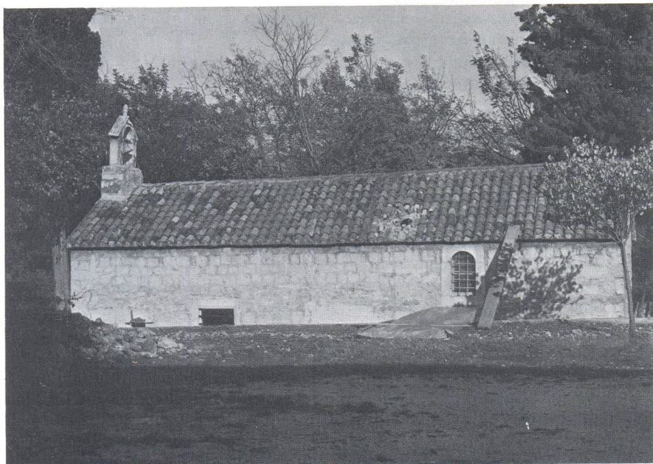
Oštećena crkva Pohodenja Blažene Djevice Marije na Špinutu
