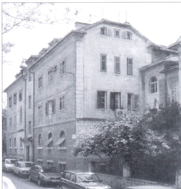
Stambena zgrada u Istarskoj ulici u Splitu sagrađena 1922. godine po projektu Dane Žagara
