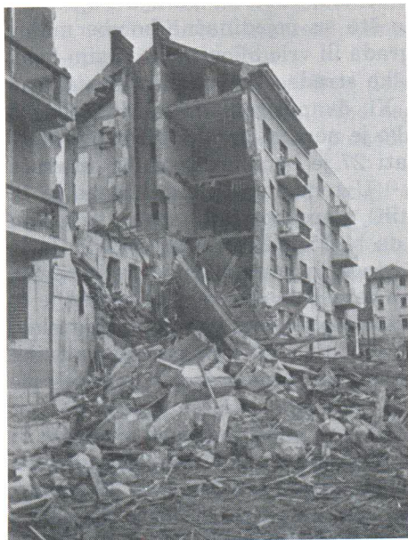
Ostaci trokatnice u bivšoj Tartaglinoj ulici (danas Ulica kralja Zvonimira 25), koja je potpuno porušena u bombardiranju Lučca 5. XII. 1943., a obnovljena u poratnim godinama
