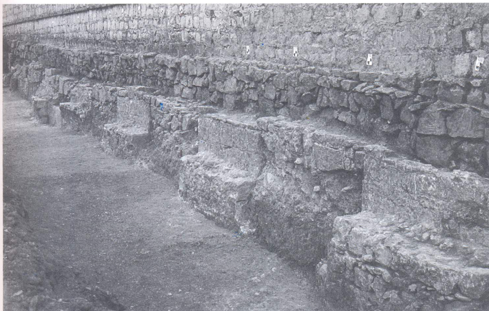
Zid vodovoda iz XIX. stoljeća nad antičkim temeljima
