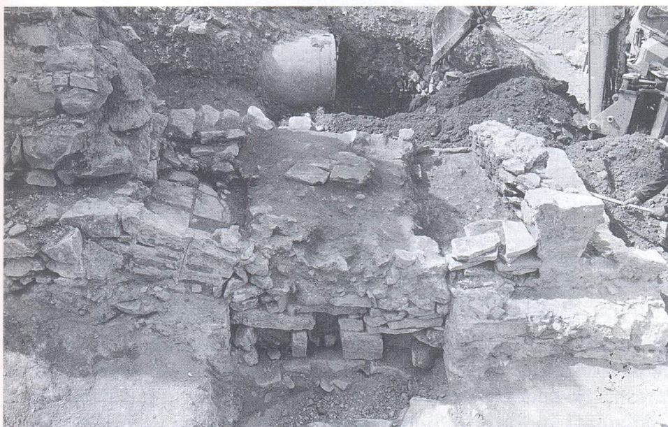
Druga faza, propust za vodu
