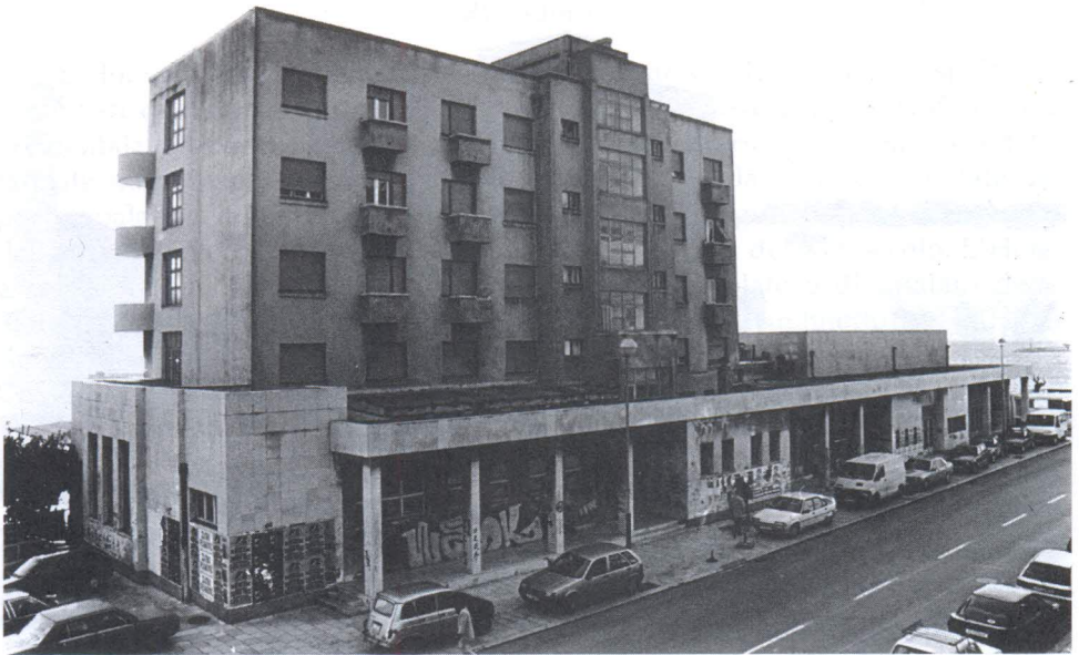
Hotel "Ambasador" zapadno pročelje, postojeće stanje
