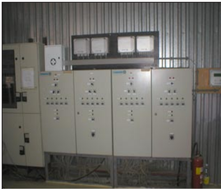
Slika. 4. Omnivent sustav za upravljanje aktivnom ventilacijom
