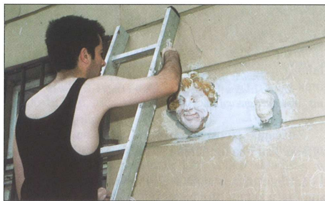
Sl. 13 Akademski slikar Domagoj Sušac intervenira na južnoj fasadi zgrade br. 6
