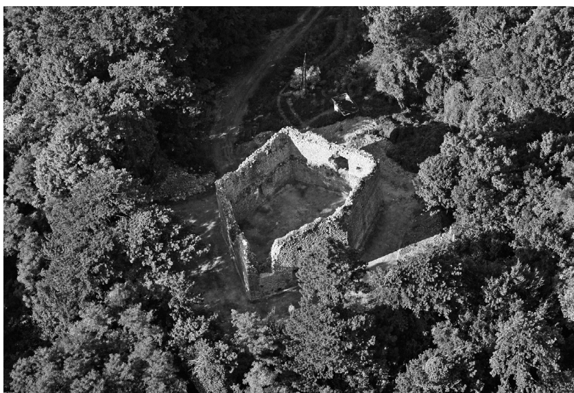
sl. 8. Utvrda Klinac (foto: J. Kliska).
