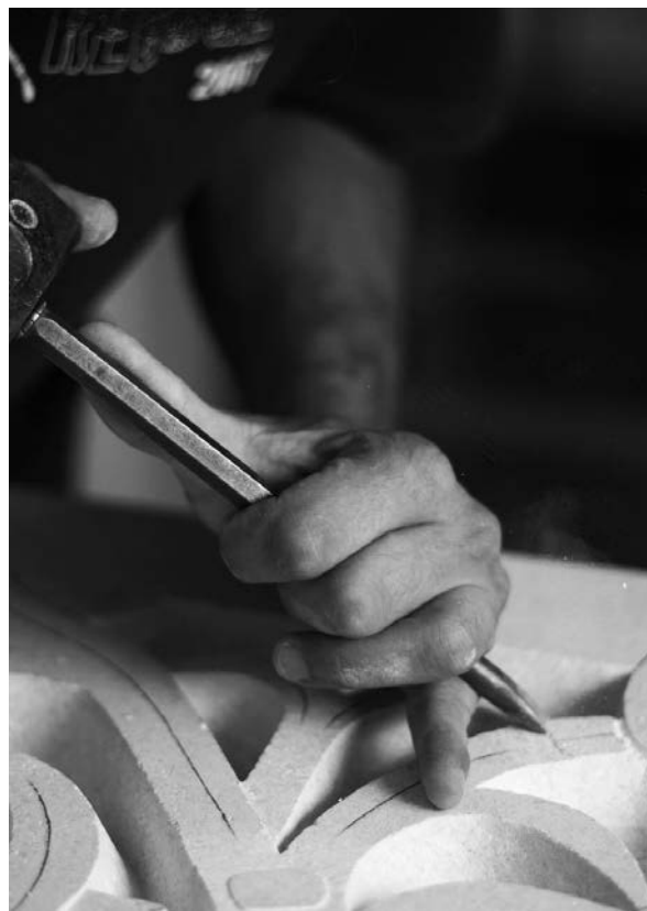
sl. 12. b. Detalj klesanja druge faze rada, obrada prepleta (foto: V. Miketek, 2012).
