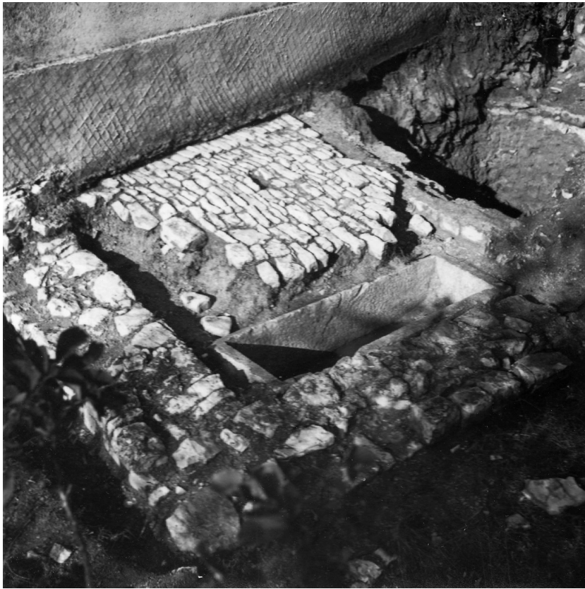
Fig. 11 North-east annexe of the nave church (building phase 5) during the 1967 excavation (MHAS archives). sl. 11. Sjeveroistočna dogradnja uz brod crkve (građevinska faza 5), tijekom iskopavanja 1967. godine (fotoarhiv: MHAS).
