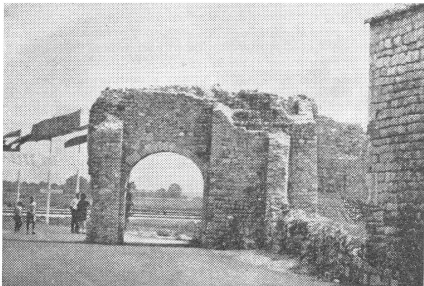
Nin, Gornja vrata, unutrašnja strana nakon popravka
