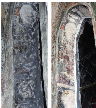
Slika 8. Prozorski otvor na istočnom zidu; stanje prije i nakon radova (fototeka HRZ-a, snimile N. Vasić 2012. i K. Gavrilica 2014.)
