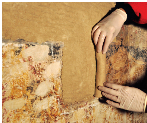
Slika 14. Uklanjanje pulpe – proba čišćenja amonij-karbonatom (fototeka HRZ-a, 2015.)
