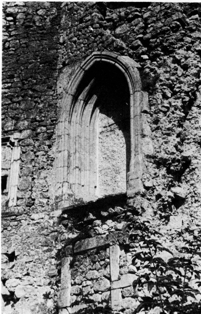
29 Zazidani portal na zapadnom pročelju, kojim se pristupalo na zapadnu emporu, ispod njega prvobitni ulaz u kapelu, a gore lijevo novi prilaz na emporu (Foto: J. Ladović 1954, Republički zavod za zaštitu spomenika kulture, Zagreb)
