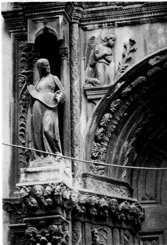
29 Južni dio prve zone portala crkve San Agostino
