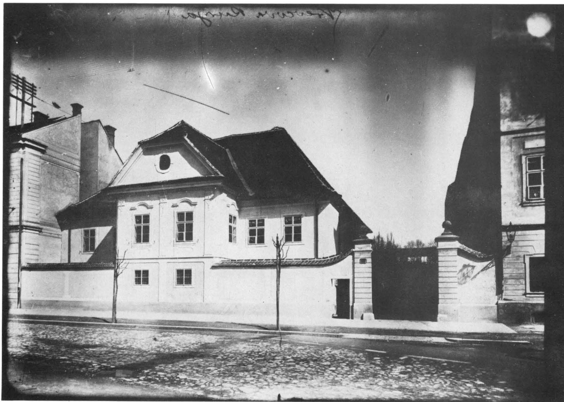
Kaptol 28, zapadno pročelje
