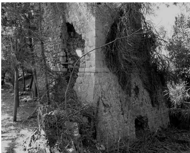
3 Kaštel Sv. Petar, kula sa sjevera Fort S. Pietro, tower from north
