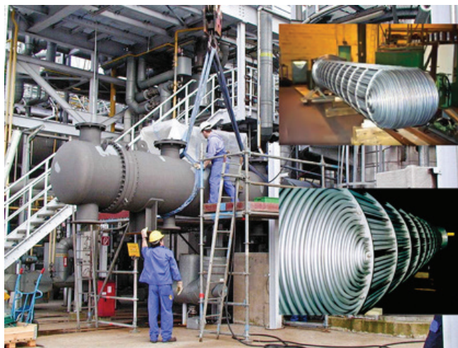
Slika – Instalacija horizontalnog termosifonskog isparivača opremljenog unaprijeđenim isparivačkim cijevima u pogonu za proizvodnju polipropilena u Knapsacku u Njemačkoj (izvor: http://www.hydrocarbonprocessing.com )
