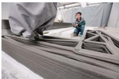
Sl.15 Tiskani dijelovi za montažnu kuću (tvrtka Winsun New Materials) [21]
