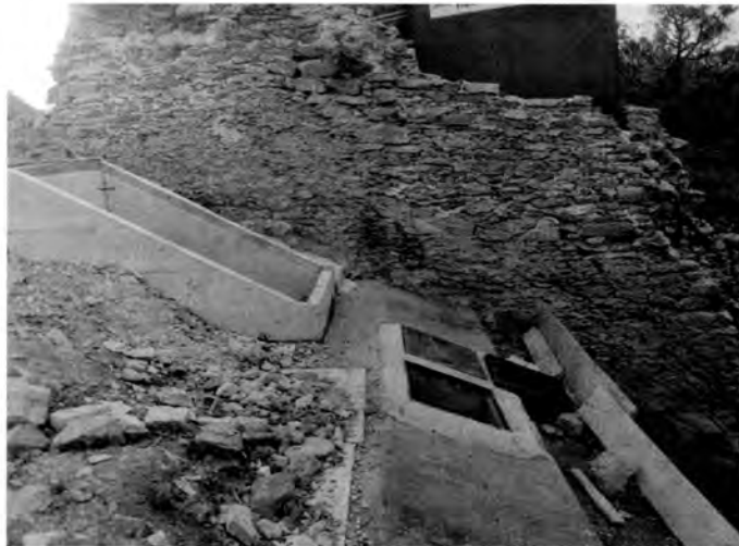
24. Medvedgrad, ugradnja vodospremnice u nasip gradske grabe, travanj 1994
