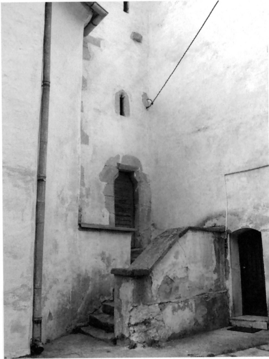
2. Obnovljeni obrambeni zvonik župne crkve sv. Brcka na Kalniku, 15-16. st., stubište zvonika. Ulaz u zvonik u visini prvog kata, stubište je prigradeno kasnije
