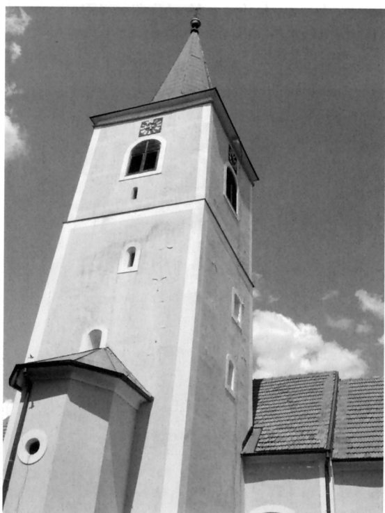
15. Župna crkva sv. Mihajla u Miholcu, obrambeni zvonik s južne strane lađe. Vanjsko stepenište do vrata zvonika u visini prvog kata dograđeno je naknadno.
