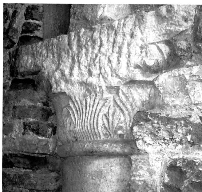
16. Začetni zid stubišta, kapitel srednjovjekovnog trijema
