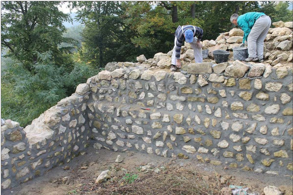
Sl. 10 Fugirana lica zidova SJ 050 i SJ 210-istok i podizanje reda kamena na sjevernom licu zida SJ 210-istok, pogled od sjevera (snimila: T. Tkalčec). Fig. 10 Grouted wall SU 050 and SU 210-east and lifting a row of stones on the north-facing wall SU 210-east, view from the north (photo: T. Tkalčec).
