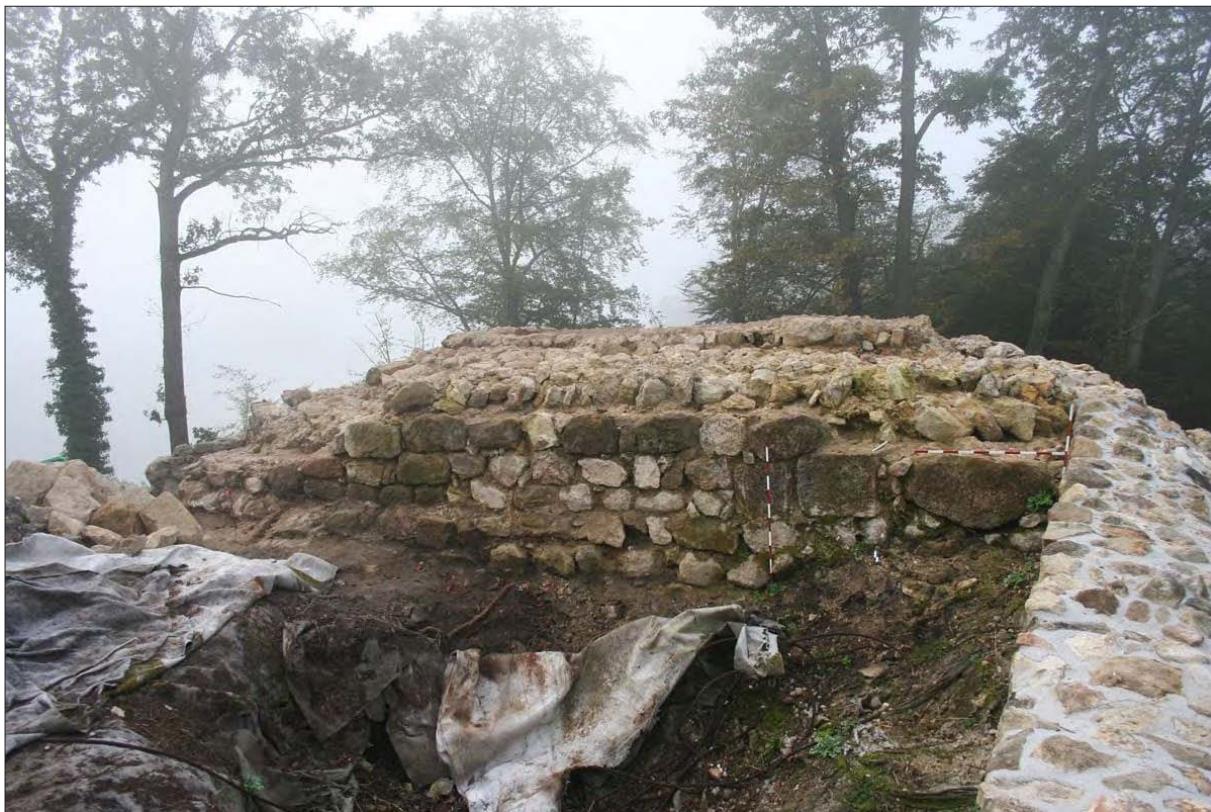
Sl. 11 Sjeverno lice zida SJ 69 prije konzervatorskih radova (snimila: T. Tkalčec, 6.10.2014.).
