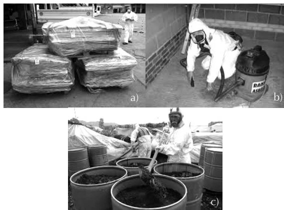
Slika 5. Priprema azbestnog otpada za odvoz i pravilna zaštita osoba
