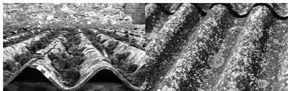
Slika 2. Mahovine i lišajevi na valovitim azbest cementnim pločama
