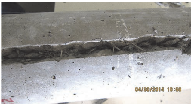
Slika 6. Vlakna u betonu uzduž presjeka pukotine
