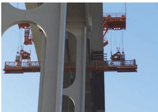
Slika 16. Podgled kolničke konstrukcije – raspon S31-S30, nanošenje završne boje [14]
