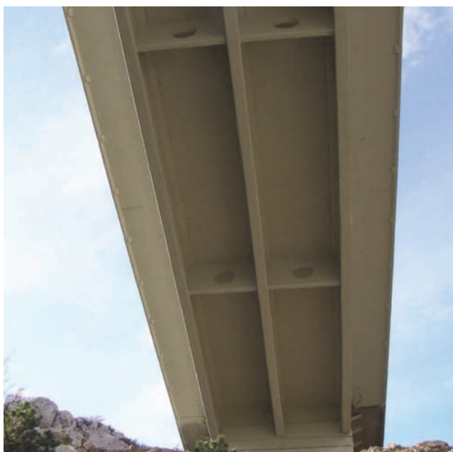
Slika 15. Podgled kolničke konstrukcije raspona U5-S31 nakon nanošenja završne boje [14]
