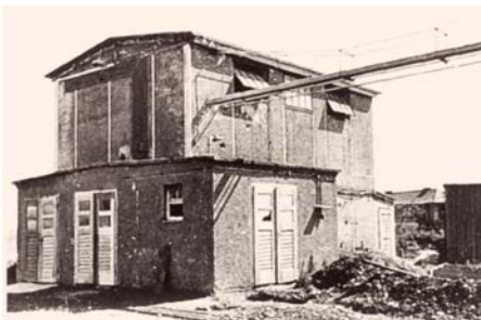
SLIKA 1. Zgrada prvog pogona za proizvodnju silikona
