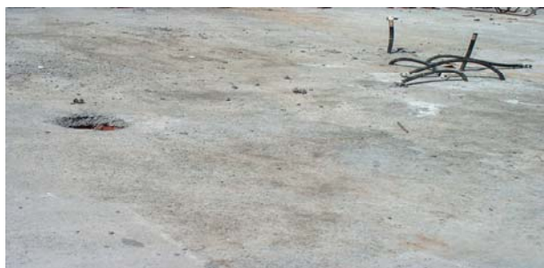
Slika 5. Nosiva betonska ploča (vijadukt «Zečeve drage» na autocesti Rijeka-Zagreb)
