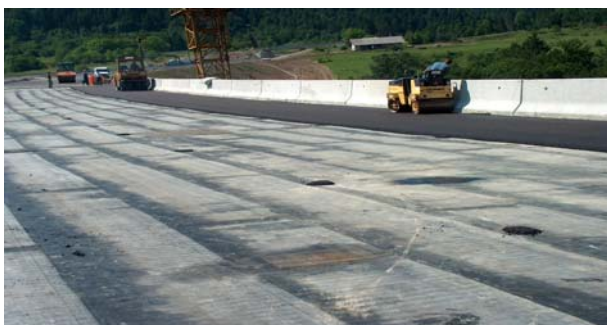
Slika 6. Vijaduk «Kamačnik» (variranje debljina zaštitnog sloja) na autocesti Rijeka-Zagreb
