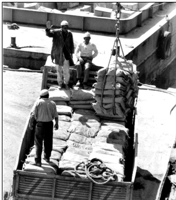
Slika 15. Prekrcaj cementa s broda na kamion; Tripoli, 1969.
