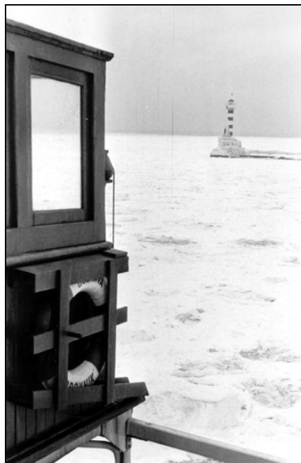
Slika 27. „Kažot“ – zaštićeni prostor na krajnjim dijelovima mosta, Iljičevsk, ožujak 1969.
