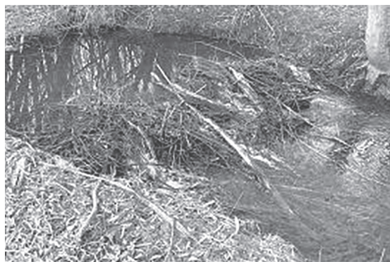
Slika 1. Dabrova brana u Podturnu na rijeci Muri
