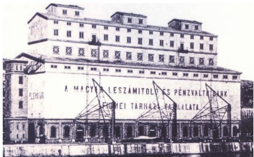
Slika 14. Žitni silos, pogled na južno pročelje [27]
