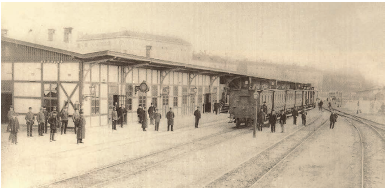
Slika 20. Stari željeznički kolodvor (1873.-1888.), južno i dio zapadnog pročelja [1]
