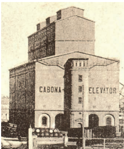
Slika 13. Žitni silos, pogled na zapadno pročelje [26]
