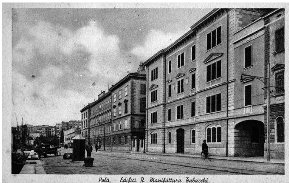
Pola - Edifici R. Manifattura Tabacchi.
