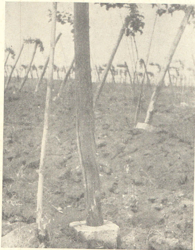
Sl. 7. Mladi nasad pergola-tendone. Armatura sa neukopanim stupovima položenim na betonsku ploču. U drugom planu vide se čelni, koso postavljani stupovi
