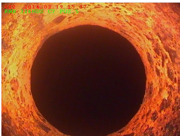
Slika 1 Primjeri korozije i naslaga u cjevovodima
