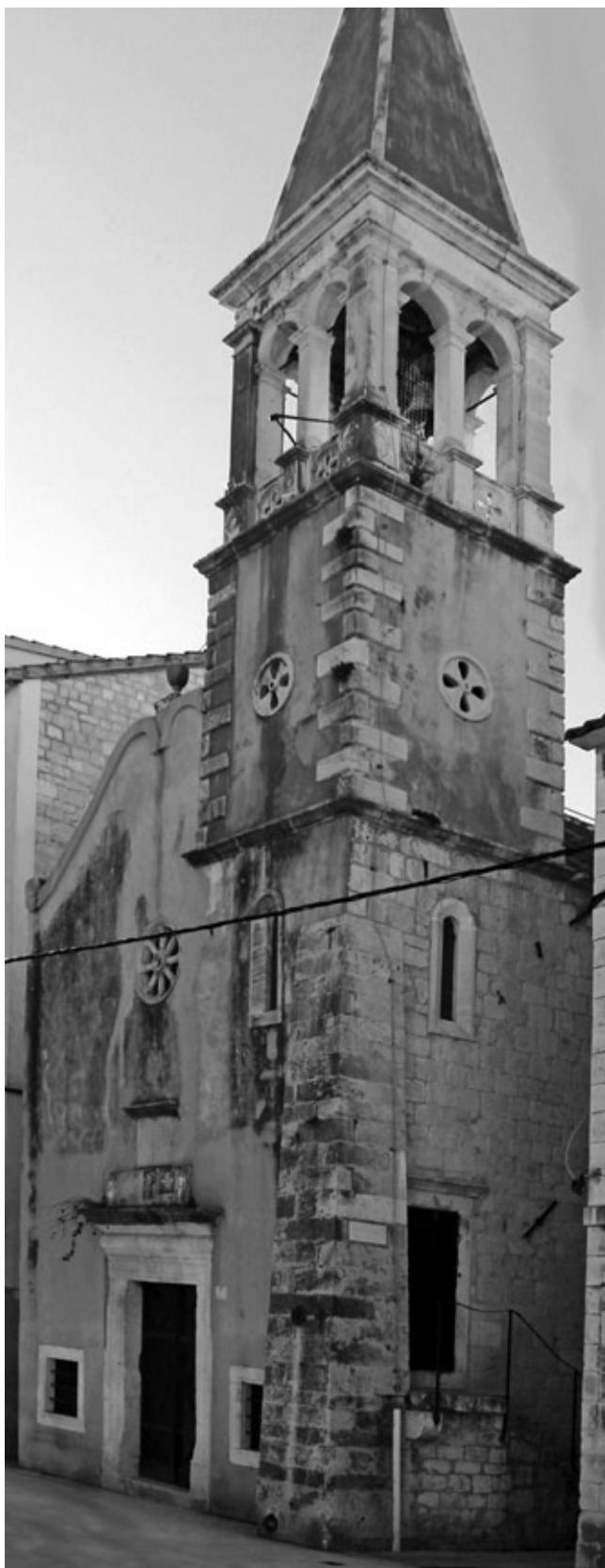
1. Pročelje crkve Gospe od Karmela, postojeće staje (foto: I. Babić) Façade of Our Lady of Carmel, present situation
